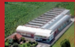
Sede storica produzione gruppi termici Historical headquarters production of burners Via Sile, 32
